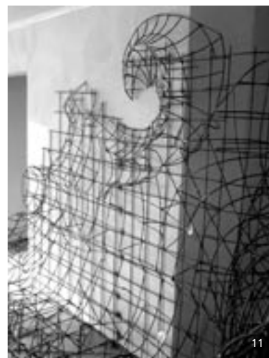
Bilder 9 und 11 Gitterformen einer Ofenbank geschweißt, Originalgröße abzüglich Putzauftragstärke.
